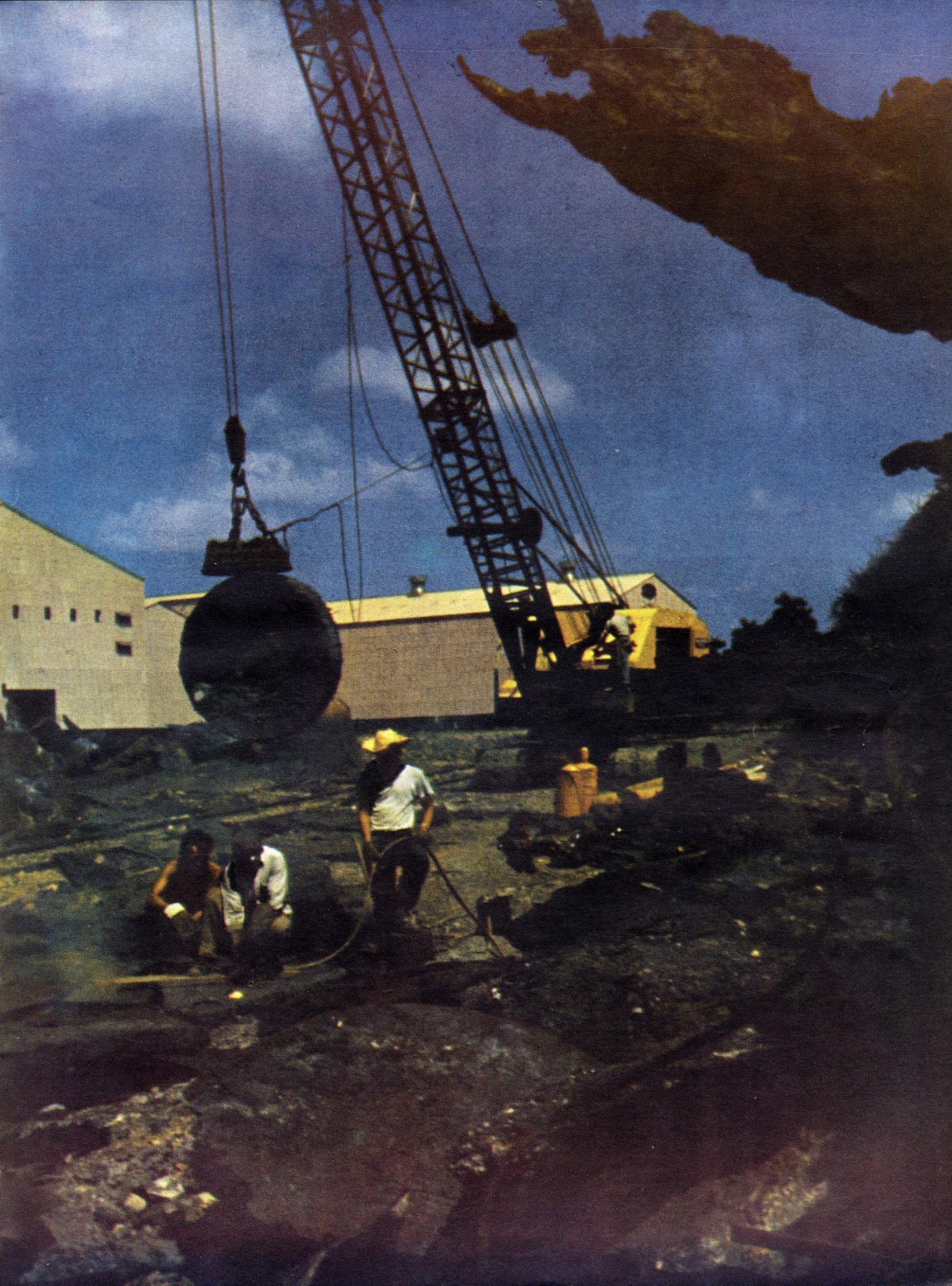
El cubilote se halla completamente lleno. Comienza la grúa a retirarlo para vaciarlo en los moldes y aún discurre la escoria por la canal del horno.
